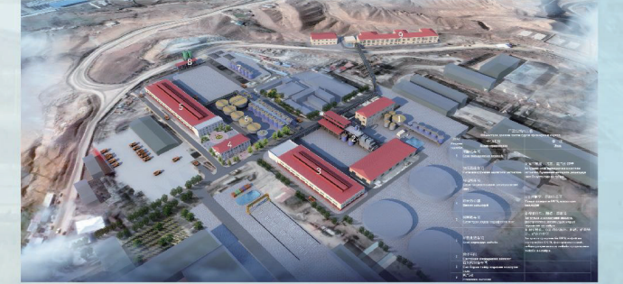
塔吉克斯坦塔罗金矿500t/d加压氧化项目 500t/d Pressure Oxidation Project of Taror Gold Mine in Tajikistan
