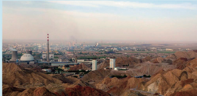
金川工程 Jinchuan Project
