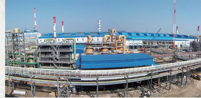
印度德里巴底吹炼铅项目 Dariba SKS Technology Lead Smelting Project, India
