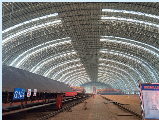
曹妃甸国际矿石交易中心项目
