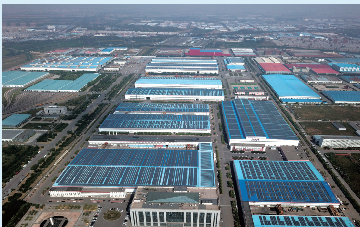
北方重工30MWp屋顶分布式光伏电站
