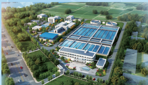
青州市东南部污水厂建设工程
