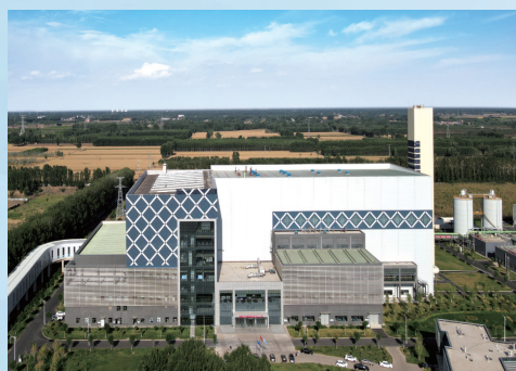
固安县生活垃圾焚烧发电厂项目
