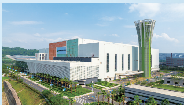
成都万兴环保发电厂(二期)项目
