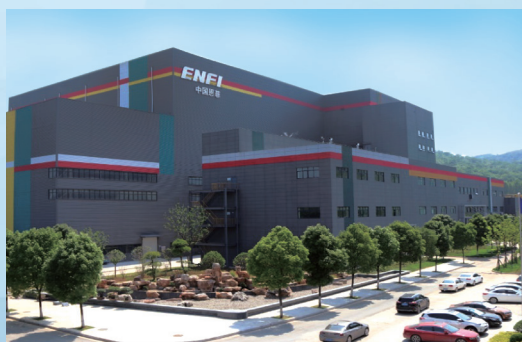
襄阳生活垃圾焚烧发电厂项目
