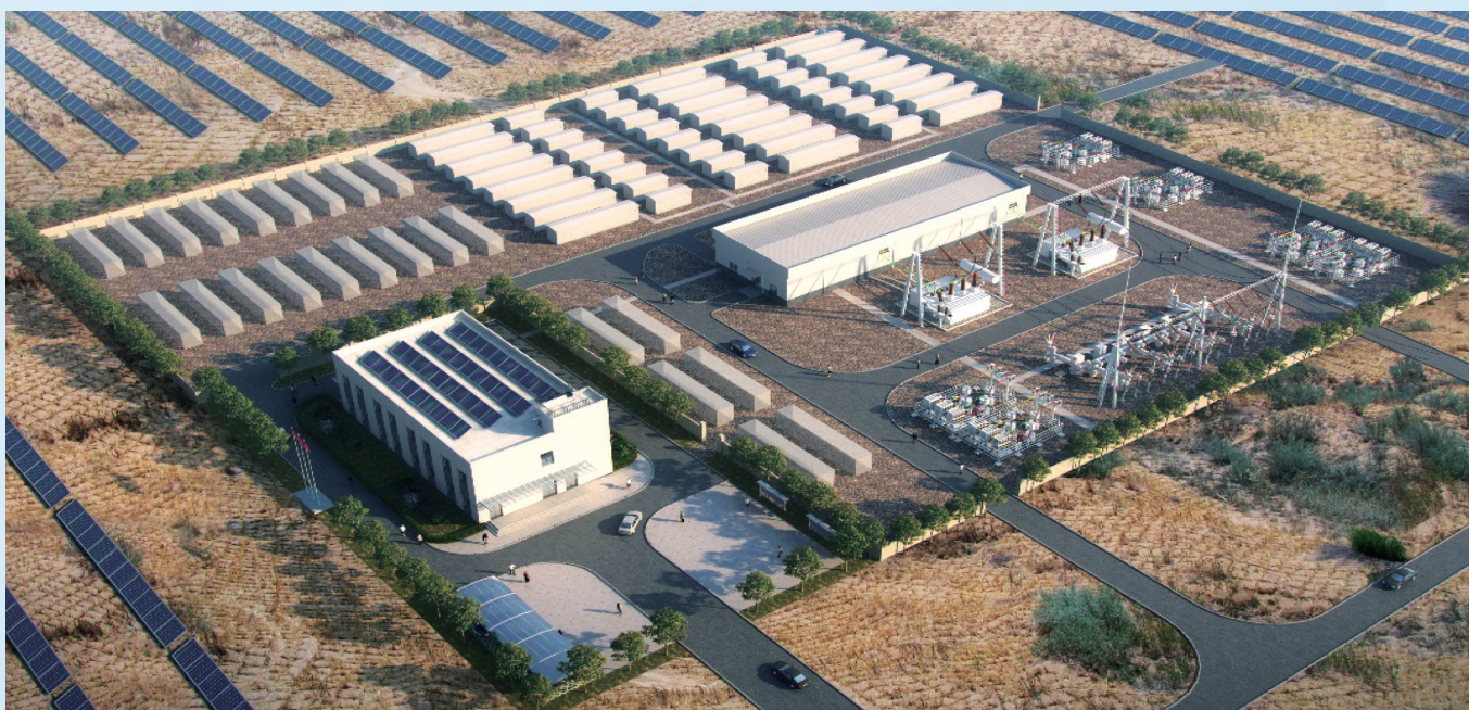
金川集团东大滩300MWp光伏电站
