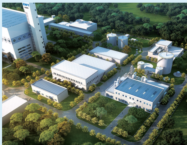
固安县有机垃圾资源化处置项目
