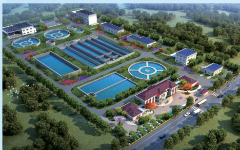
安陆市经济开发区工业污水处理厂及配套 管网工程
