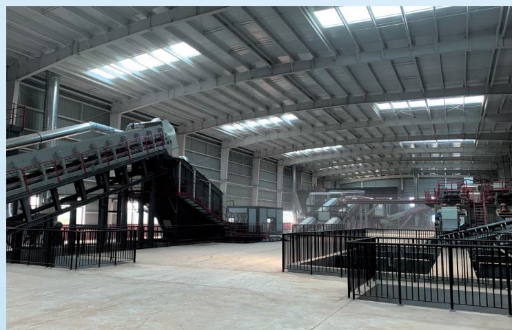
容东片区再生建材场项目
