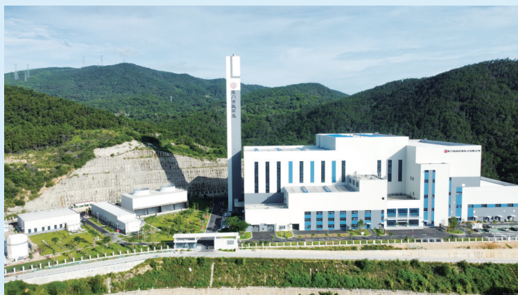
厦门东部垃圾焚烧发电厂三期工程项目
