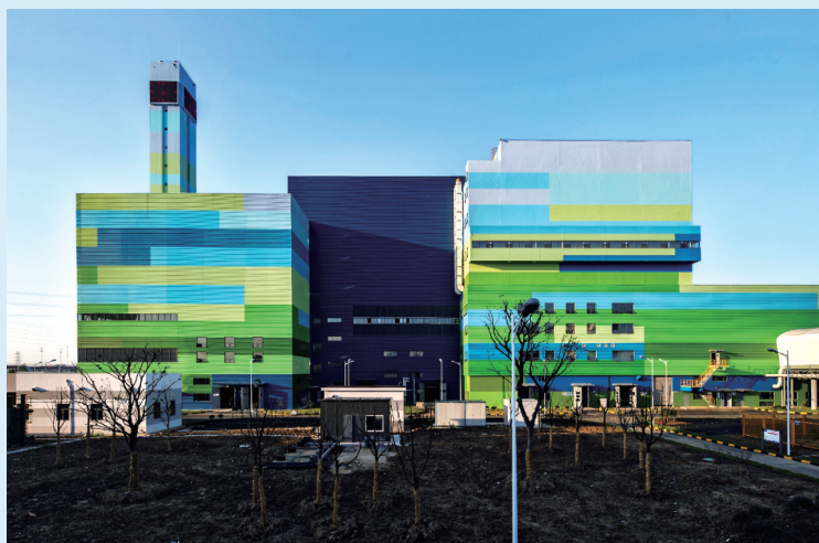
无锡市锡东生活垃圾焚烧发电厂项目
