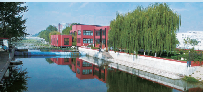
污水处理厂及配套管网项目
