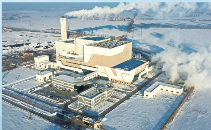
生物质采暖锅炉房—吉林榆树垃圾焚烧发电项目
