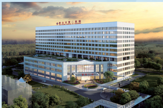
唐山市第二医院新建骨科大楼项目
