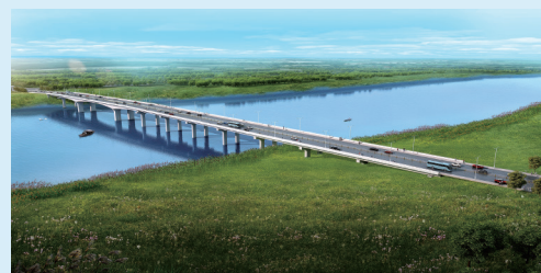
安陆市府河三桥建设项目
