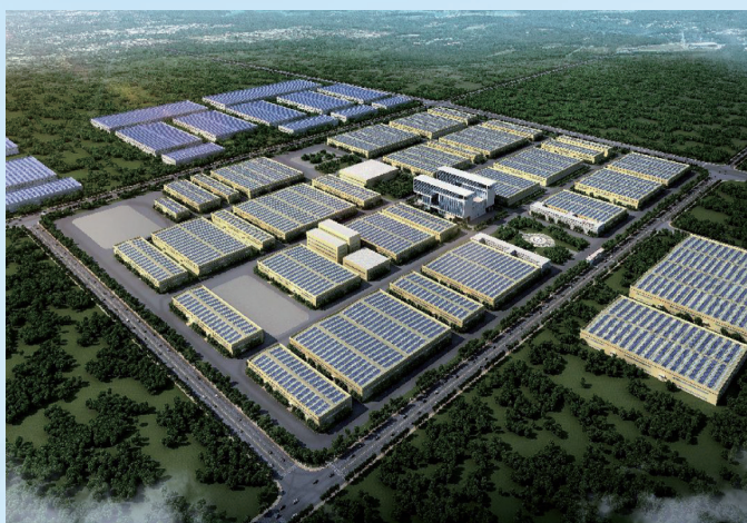
沈阳机床集团36MWp屋顶光伏电站
