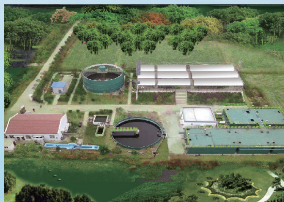
安陆市乡镇生活污水治理工程
