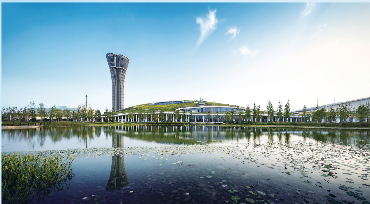
雄安新区垃圾综合处理设施项目
