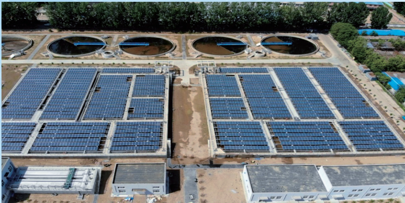
北京良乡污水厂分布式光伏电站
