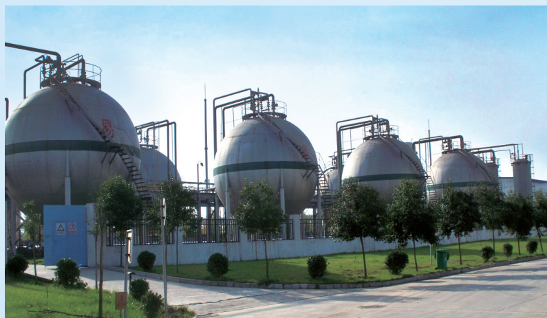
氢气站—中硅高科多晶硅扩建项目
