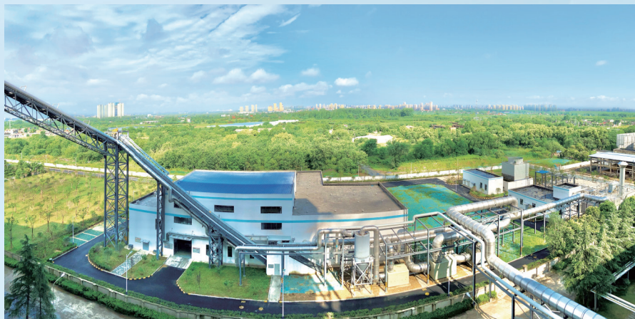
合肥市污泥干化协同焚烧项目
