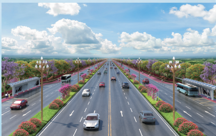
西昌市2020年机场路维修改造提升项目
