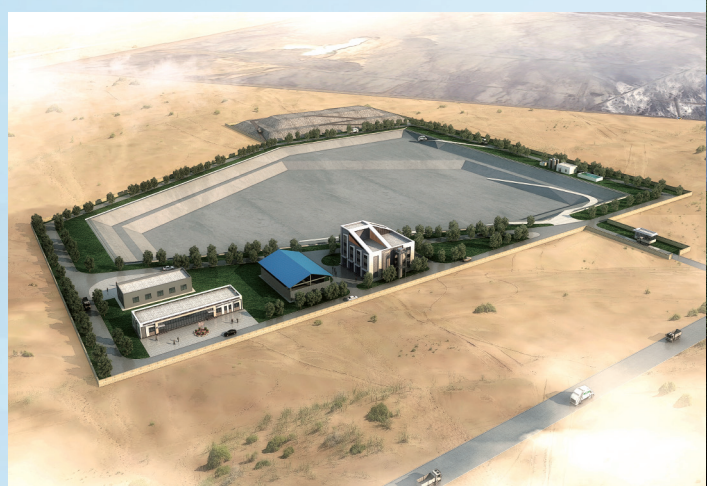
金昌市危险废物资源化处置项目
