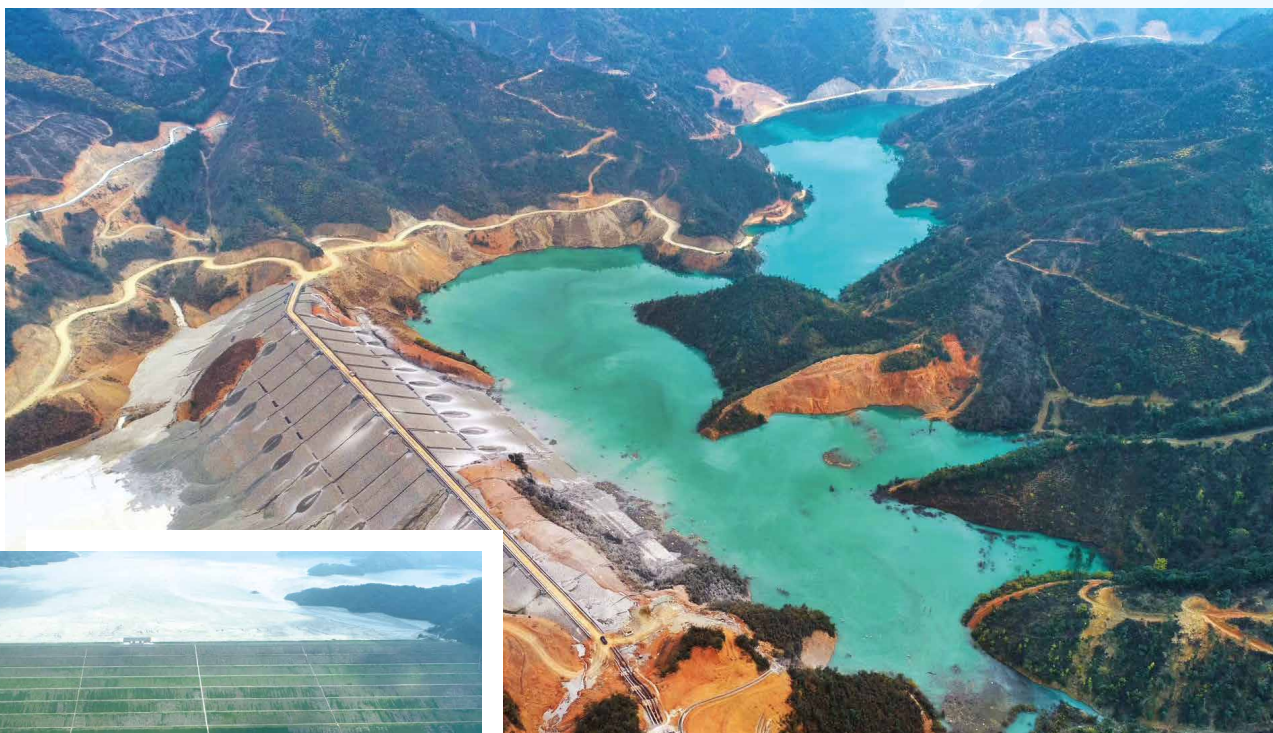
亚洲最大尾矿库——德兴铜矿5号尾矿库 总库容10.31亿 \text{m}^3 ，总坝高222m，一等库
