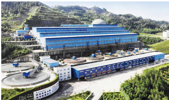
国家优质工程奖——都龙铜锌锡多金属矿新田选矿厂 全球日处理量最大单系列锌锡铜多金属选矿厂，规模297万t/a 国内首次实现半自磨-球磨系统磨矿专家智能控制
