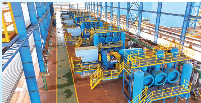
印尼首条红土镍矿浆体长距离管道输送工程 ——华越镍钴矿浆体管道工程 输送镍钴原矿520万t/a，管道长61km，压力高达10MPa 6台隔膜泵并联输送
