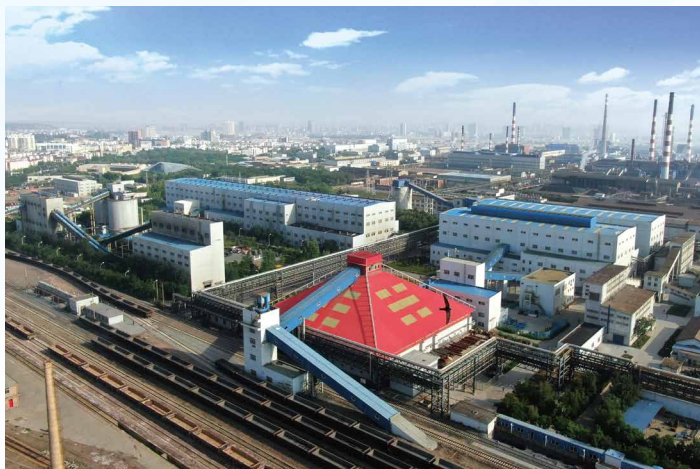
国内生产能力最大的镍选矿厂——金川工程选矿厂 三个磨选系统，一选14000t/d，二选11000t/d和4500t/d 三选6000t/d，两个精矿浓缩过滤系统
