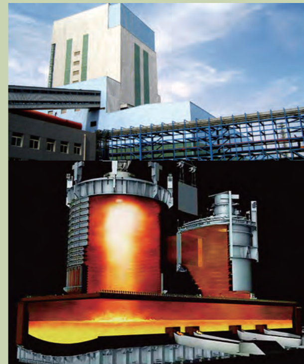
金川集团镍闪速炉车间
