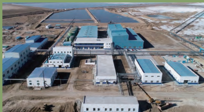
五矿盐湖一里坪锂盐EPC总承包项目
