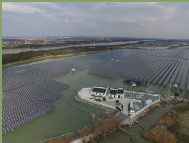
■ 嘉善德源50MW渔光互补电站
