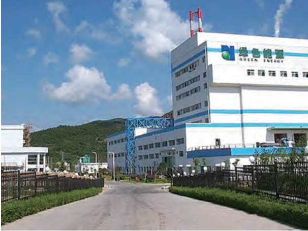
★ 宁波枫林垃圾焚烧发电厂 1050t/d, 13.6MW, 国内首个千吨级垃圾焚烧项目， 2001年投产。
