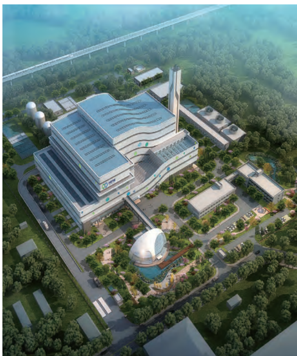
★ 中节能衡水垃圾焚烧发电厂 600t/d, 已投产。
