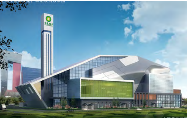
★ 北京通州区再生能源发电厂二期 1700t/d (2×850t/d)，建设中。
