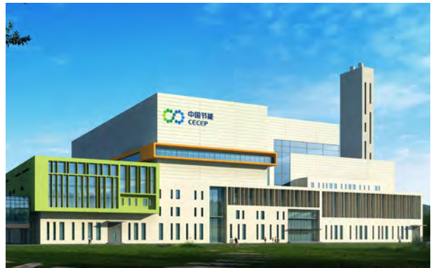
★ 临沂市第二垃圾焚烧发电厂 1500t/d，建设中。
