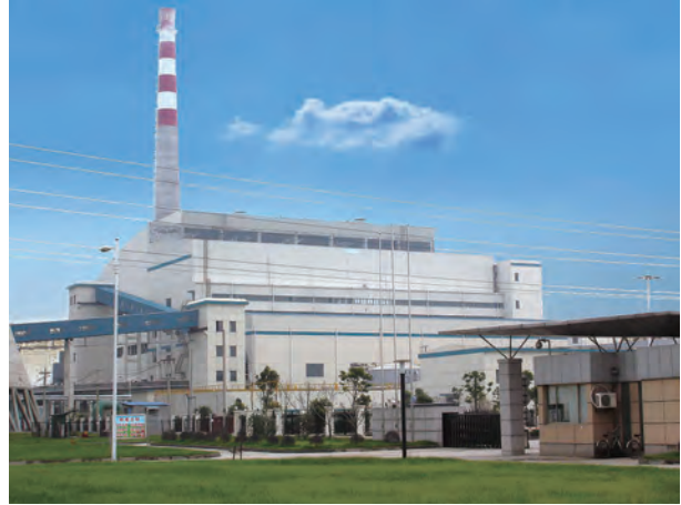
★ 无锡惠联生活垃圾焚烧发电厂 1200t/d, 24MW, 2006年投产。
