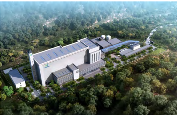
★ 丽江市生活垃圾焚烧发电项目（一期工程） 600t/d，已投产。
