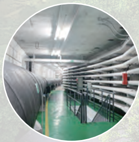
城市综合管廊工程
