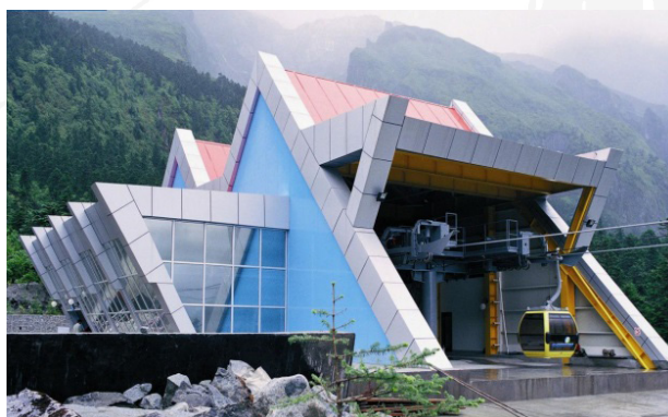
▲ 四川海螺沟索道下站房（实景）
